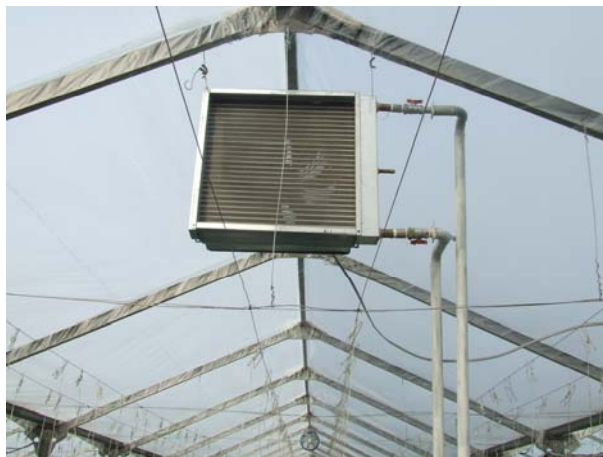
სურათი 4 - ცხელ წყალზე მომუშავე კალორიფელი
