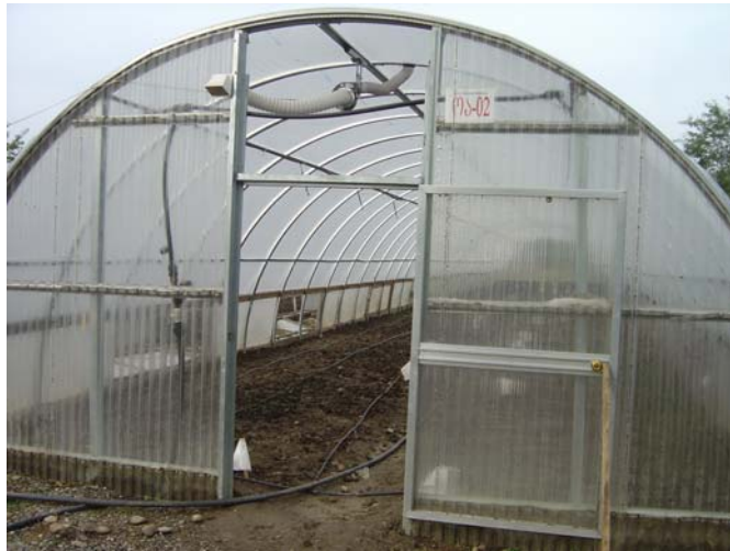
სურათი 5 – ანგარული (რკალური) სათბური, ორმაგი, გასაბერი პოლიეთილენის ფირის საფარველით
