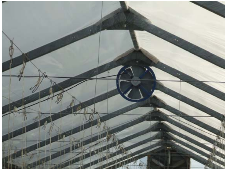
სურათი 7 - ჰაერმიმოცვლისთვის სათბურის შიგნით დამონტაჟებული ვენტილატორი
